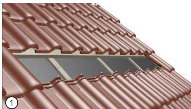
Prace rozpoczynamy od demontaży części dachówek – występujących w miejscu planowanego umieszczenia zestawu ochrony przeciwśniegowej.
