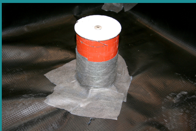
Joonis 5. Läbiviigud liimitakse butüülliimiga ja tihendatakse tihendusteibiga.
