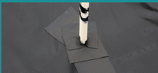
Joonis 14. Läbiviik on tihendatud!
