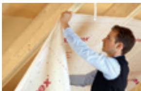
Aurutõkke paigaldamine
